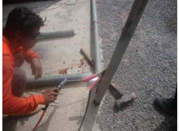
รูปที่ 10,11 นำท่อเหล็กมาเชื่อมเป็นรูปตัว L
