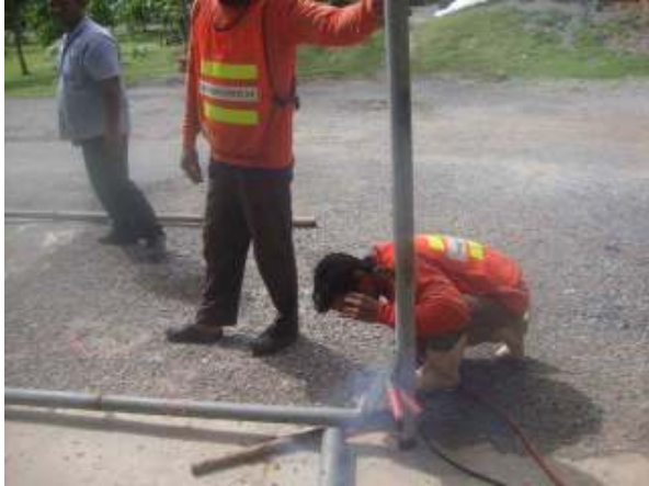
รูปที่ 10,11 นำท่อเหล็กมาเชื่อมเป็นรูปตัว L
